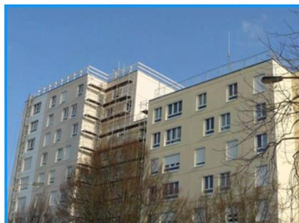
Intervention sur les façades : imperméabilisation et embellissement, réfection de l'étanchéité et sécurisation des terrasses, remplacement des volets roulants.
